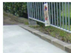
段差がなくなりました
