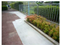
段差がなくなりました
